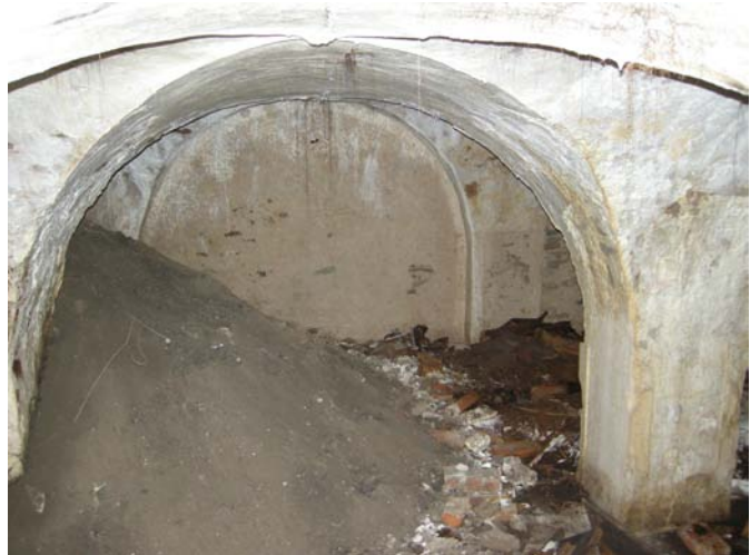
Erster Foto nach Entfernung eines Ziegels. Blick auf das zweite Viertel des Raumes (4.2)
